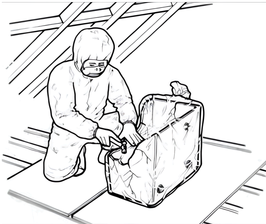
Figura 8 – Remoção de reservatórios tipo caixa d'água em FCA. DISPONÍVEL EM: http://www.hse.gov.uk/pubns/guidance/a15.pdf . ACESSO EM: 10 maio 2025.
